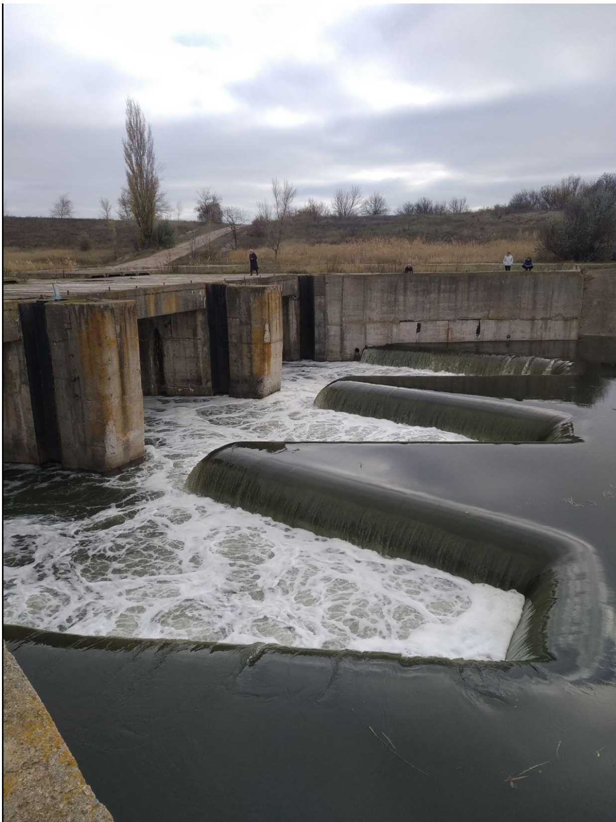
Рисунок 5 - Полігональна плотина на входному оголовку в тунель, км 198,37 каналу Дніпро – Донбас
