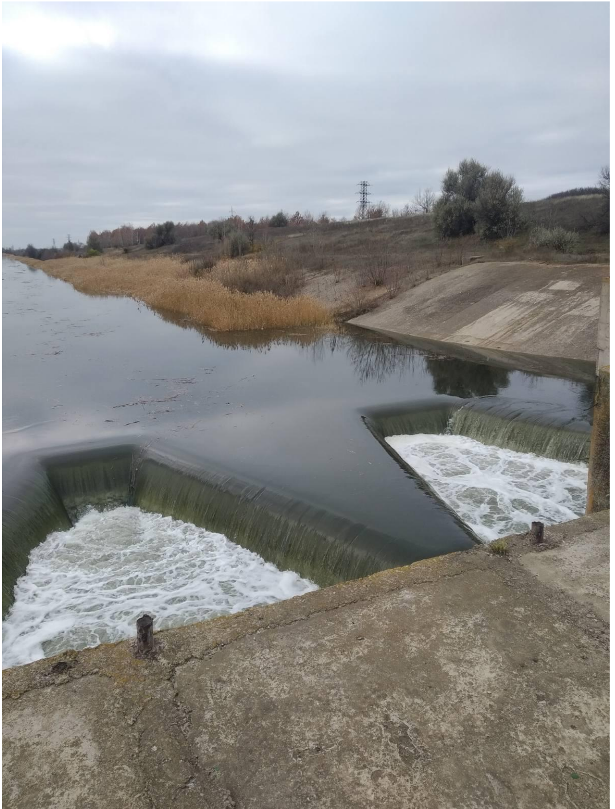
Рисунок 6 - Полігональна плотина на входному оголовку в тунель, км 198,37 каналу Дніпро - Донбас
