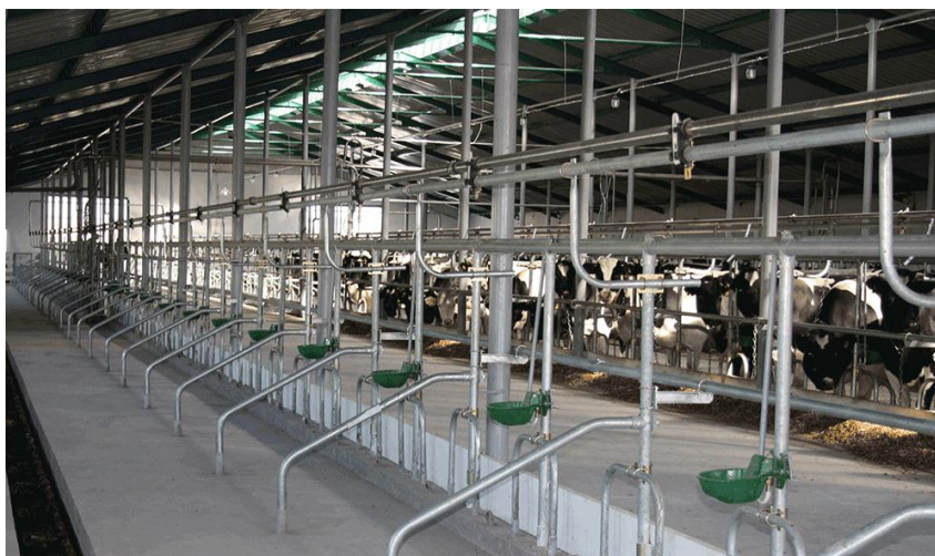
Рисунок 2.3 – Загальний вигляд доїльної установки УДМ-200
