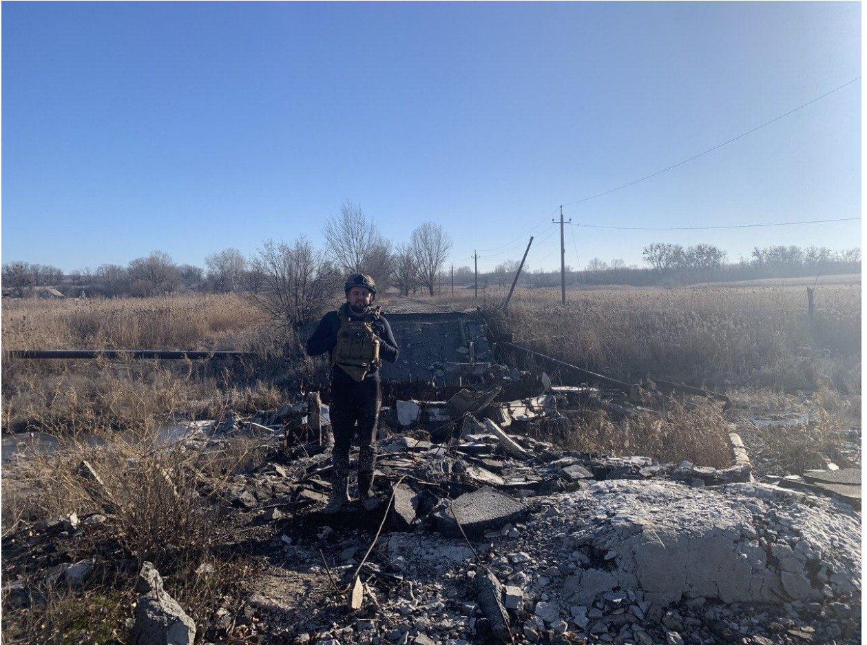
Рисунок В.1 – Зруйнований міст через р. Нітріус. (грудень 2022 р., ТОВ «ТОПОГРУП»)
