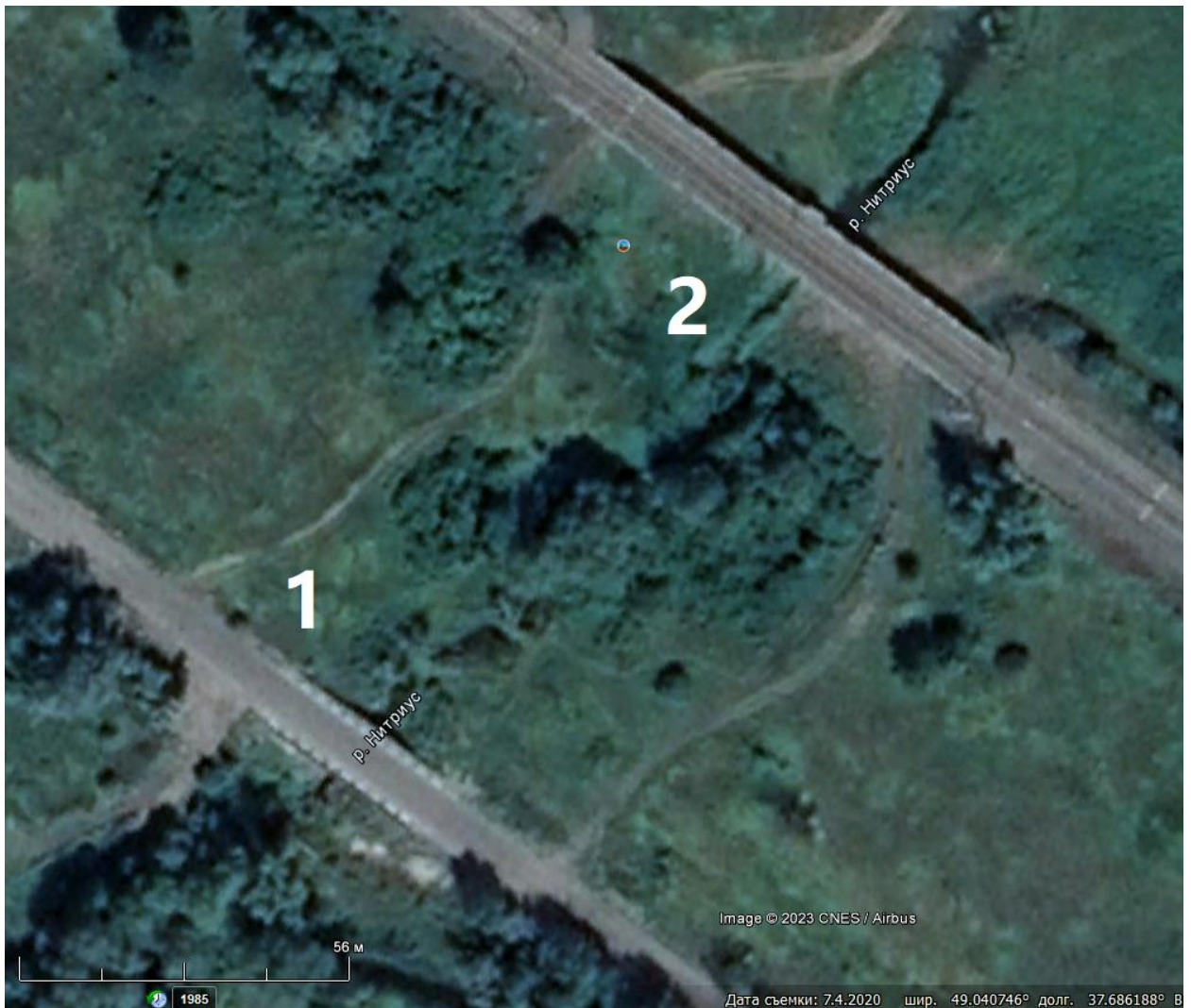
Рисунок 2.1 – Розташування мосту на р. Нітриус (Google Earth Pro, фото 07.04.2020 р.): 1 – автомобільний міст – об'єкт проектування, 2 – залізничний міст
