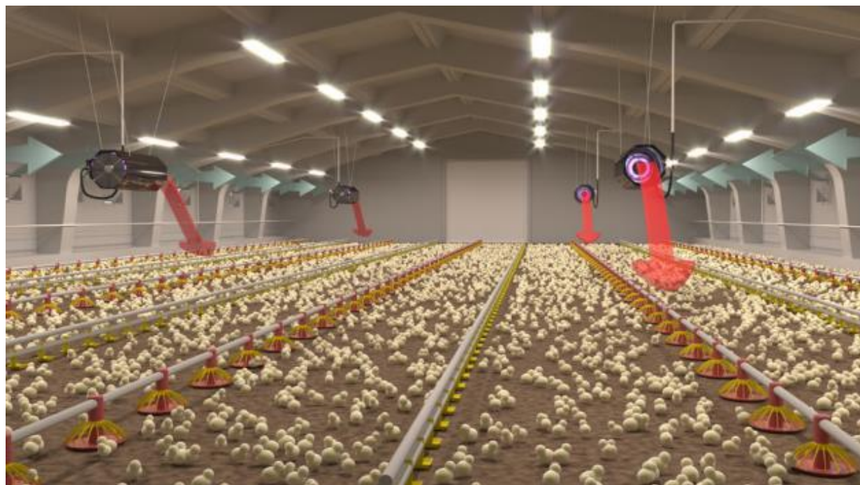
Рисунок 1.6 - Циркуляція повітря з використанням газової гармати
