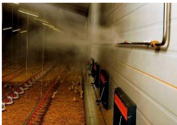
Рисунок 1.7-Форсунки зрошення для кондиціонування повітря влітку
