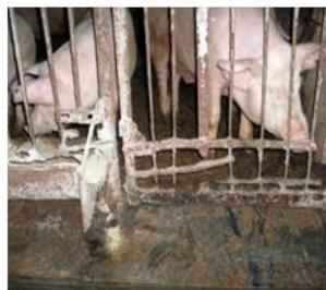
Корозія деталей огорож свинарника
