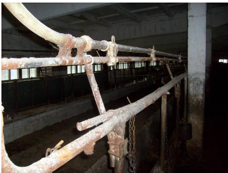
Рисунок 1.14 – Корозія труб, які застосовуються для закріплення прив'язків тварин у корівнику дійного стада
