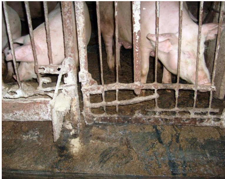
Рисунок 1.11 – Корозія деталей огорож свинарника
