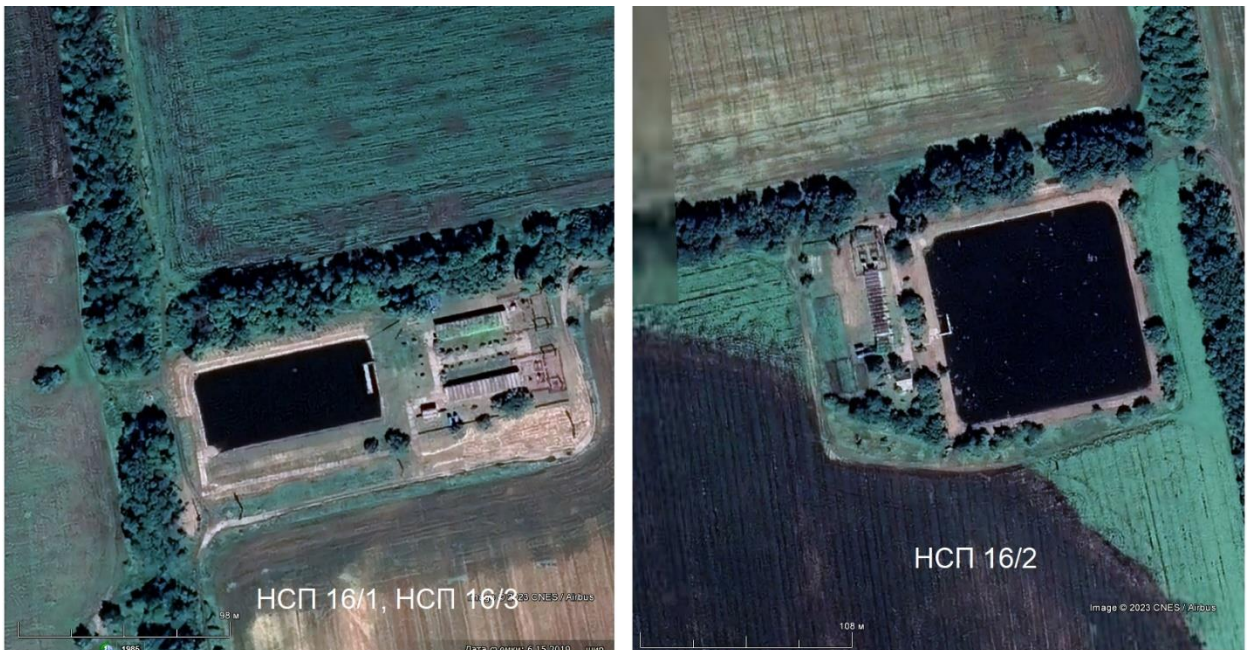
Рисунок 2.10 – Насосні станції підкачки. Google Earth (14.07.2021 р.),
