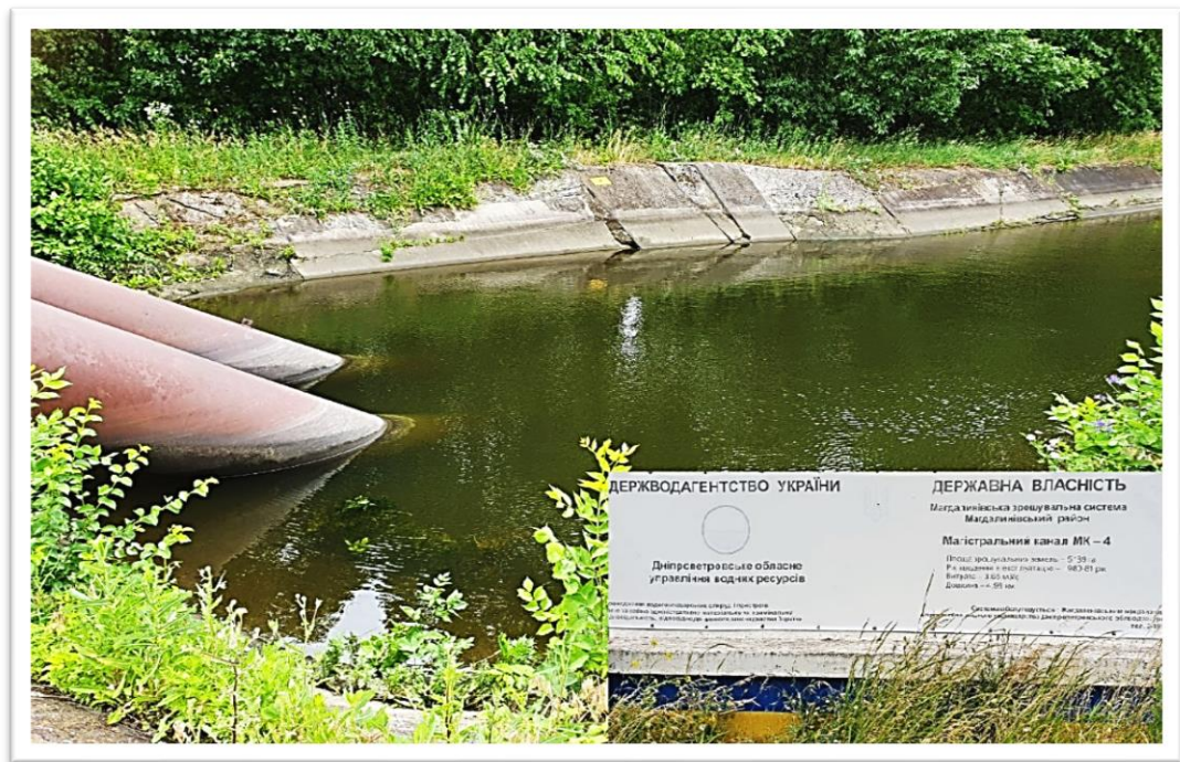
Рисунок 2.3 – Магістральний канал МК – 4.
