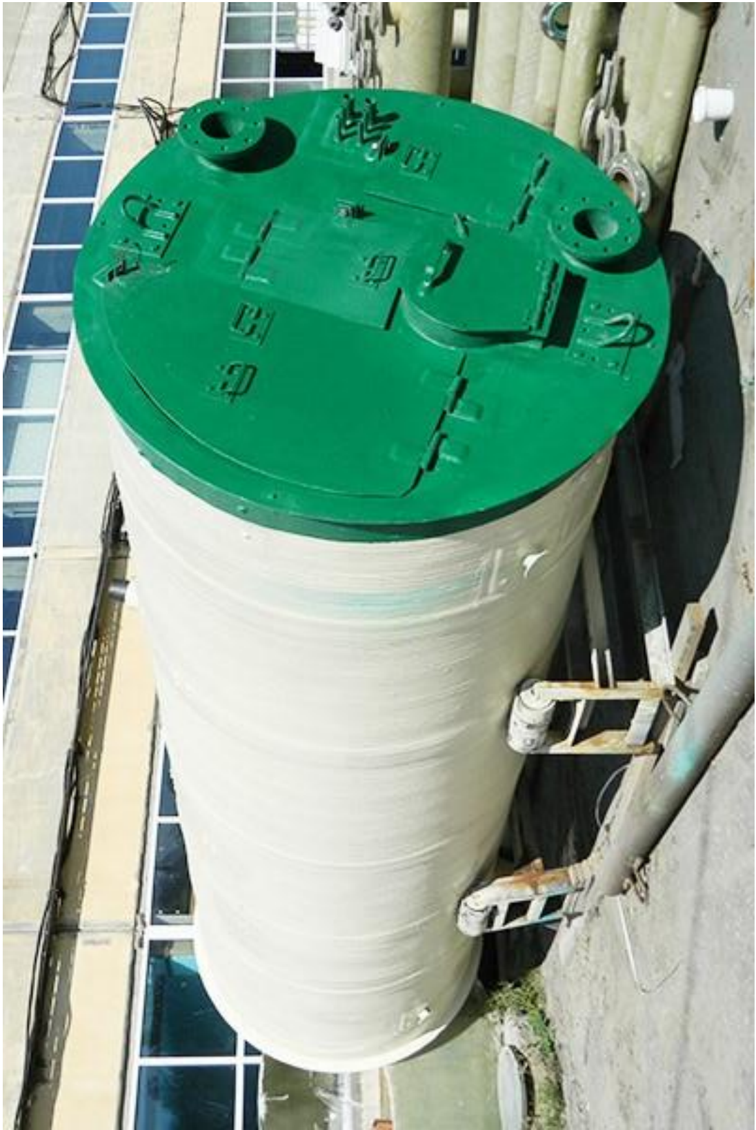
Рисунок 6.1 – Конструкція КНС
