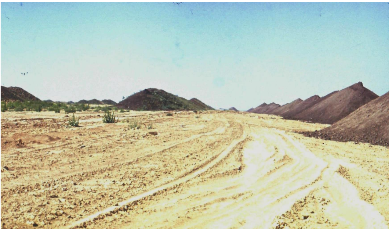
Рис. 6. Выровненная поверхность отвала из лессовидных суглинков подготовлена для покрытия плодородным слоем чернозема южного. Запорожский карьер Орджоникидзевского ГОКа, 1970 г.
