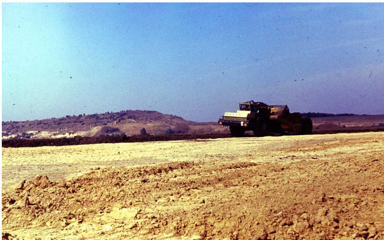
Рис. 7. Нанесение плодородного слоя почвы автоскрепером, 1974 г.
