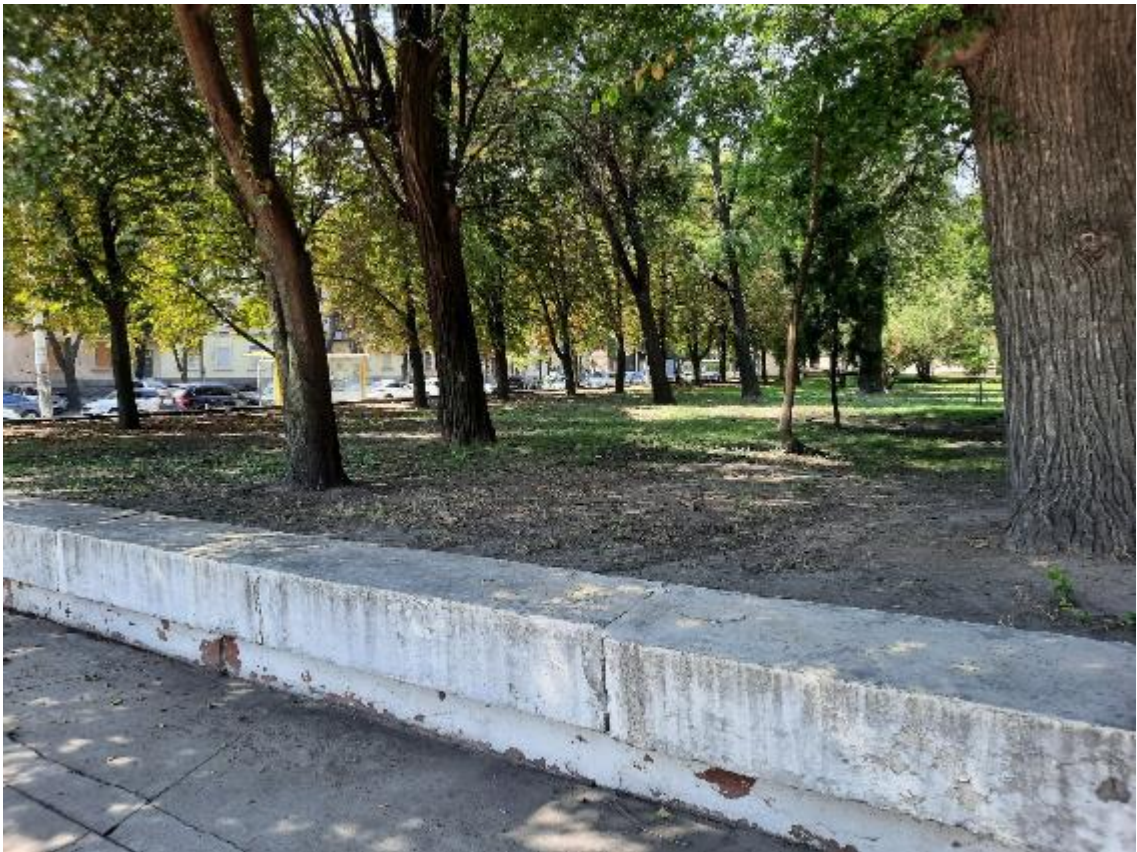
Рисунок 2.5. Підпірні стінки по периметру території парку Пам'яті та Примирення
