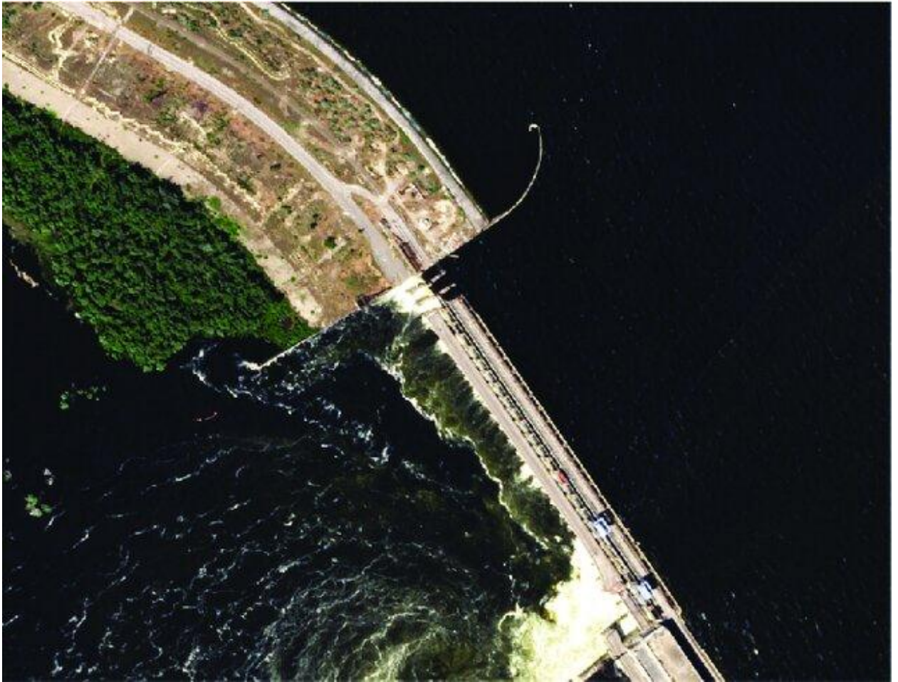
Рисунок 1.2 Супутниковий знімок пошкодженого водозливу Каховської дамби перед її руйнуванням [3].
