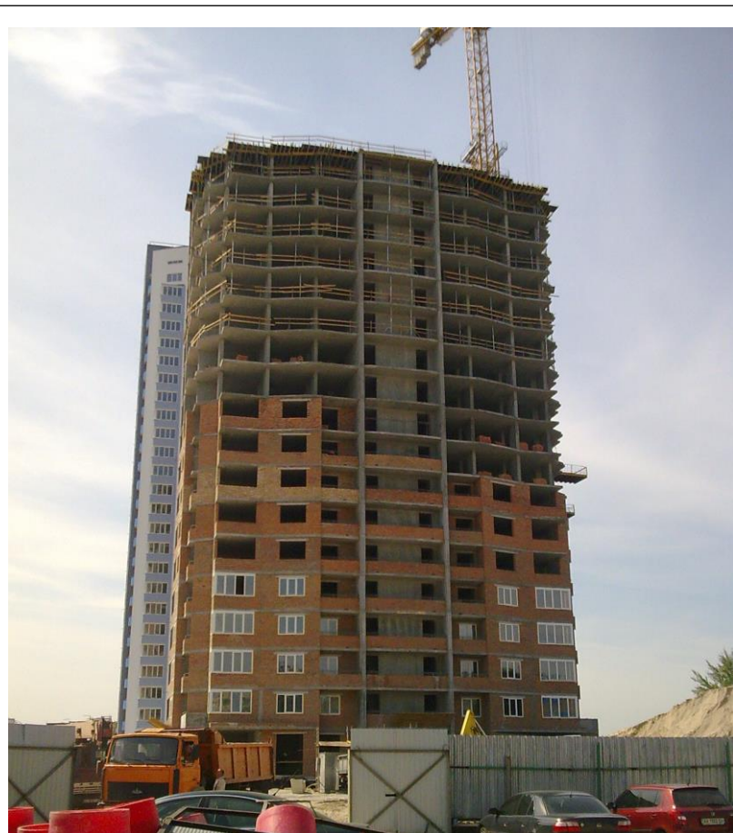
Рисунок 6 – Общий вид строящихся 27-этажных жилых домов по Оболонскому проспекту в г. Киеве с системой виброизоляции (расположением на расстоянии 100 м от линии метрополитена мелкого заложения)
