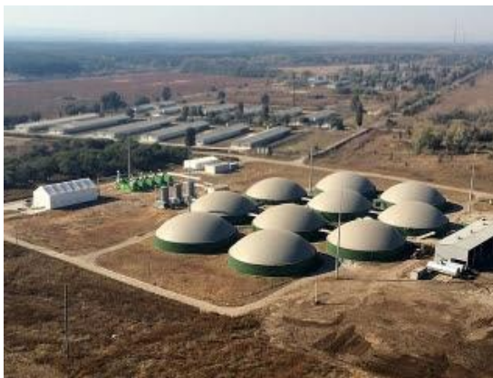
Рисунок 1.2 - Біогазова станція на птахофабриці ПрАТ «Оріль-Лідер» переробляє курячий послід та стічні води у біогаз
