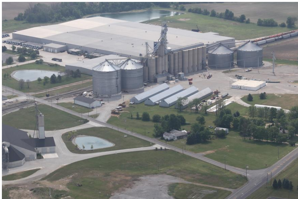
Рисунок 1.1 – Загальний вигляд території елеватора ТОВ «Белгравія»
