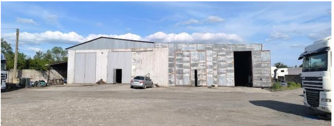
Будівля та територія СТО
