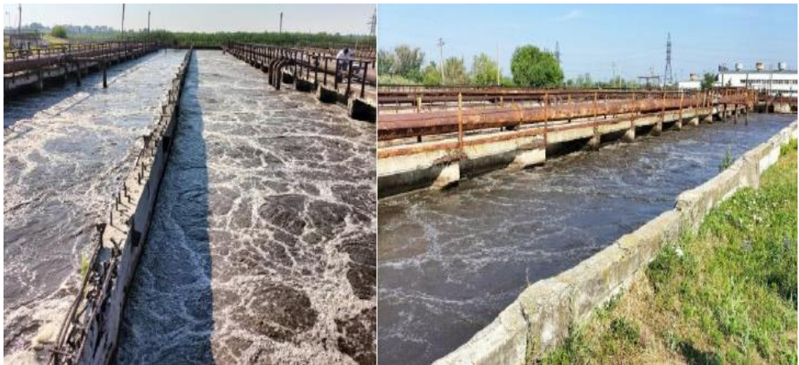
Рисунки 1.9–1.10 - Блок біологічного очищення – аеротенки
