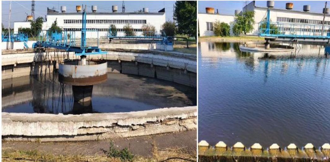
Рисунки 1.11–1.12 - Вторинні радіальні відстійники
