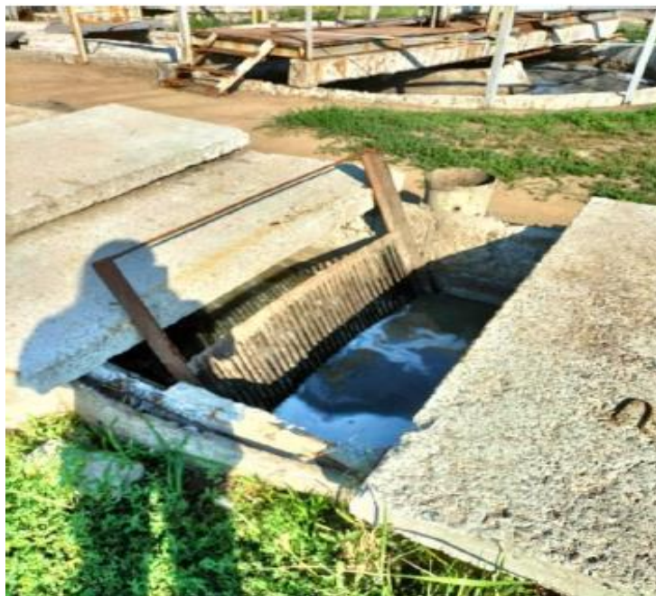
Рисунок 1.4 – Вловлюючі решітки (решітки-дробарки)
