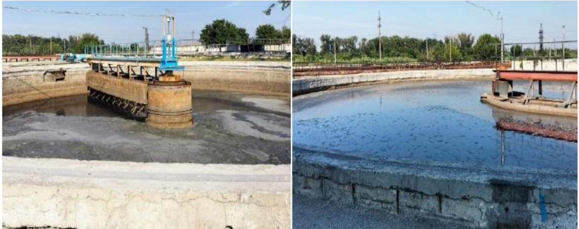
Рисунки 1.6–1.7 - Первинні радіальні відстійники
