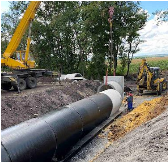
Рисунок 4.3. Технологія улаштування водопропускних труб (кульверт)
