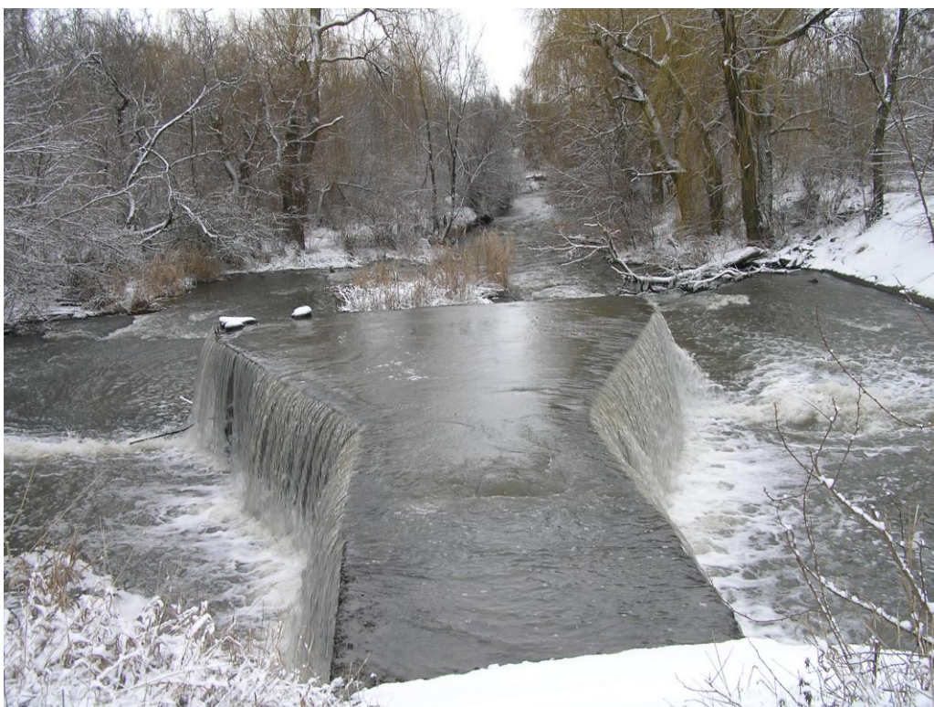
Рисунок 2.4 – Низовий укіс греблі. Вид на ковшовий гасник енергії (фото №4)
