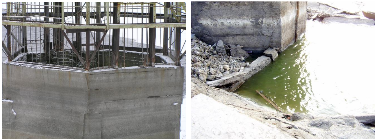
Рисунок 2.5 – Башта шахтного водоскиду (фото №5)
