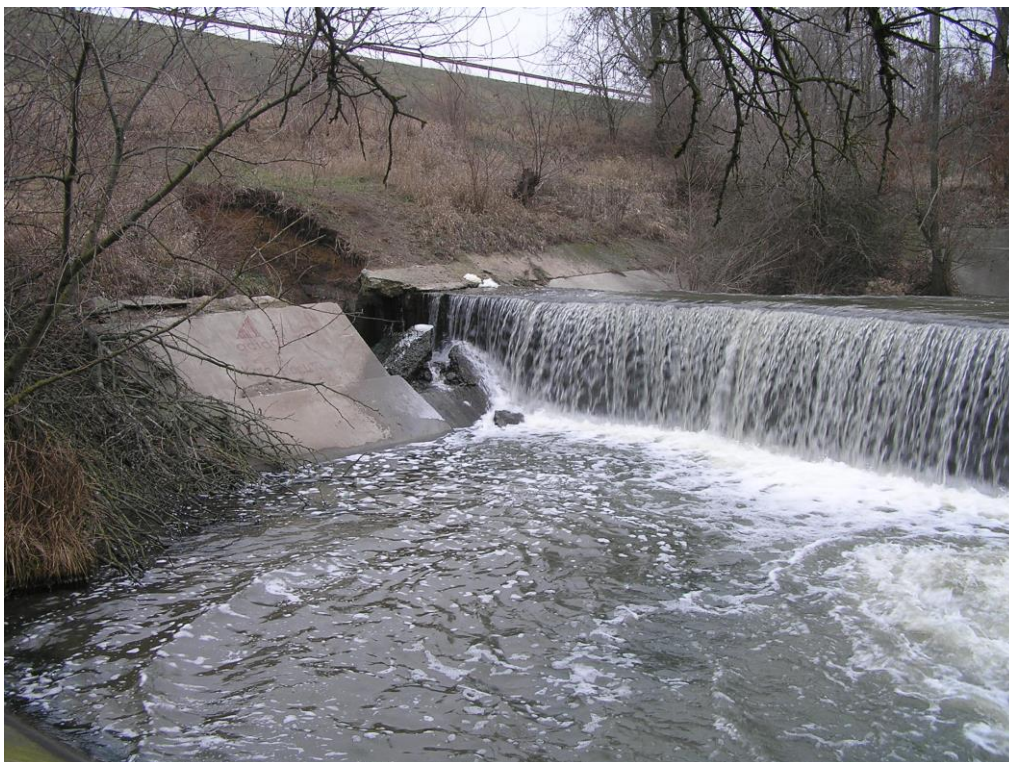
Рисунок 2.3 – Низовий укіс греблі. Вид на водоскидну споруду (фото №3)
