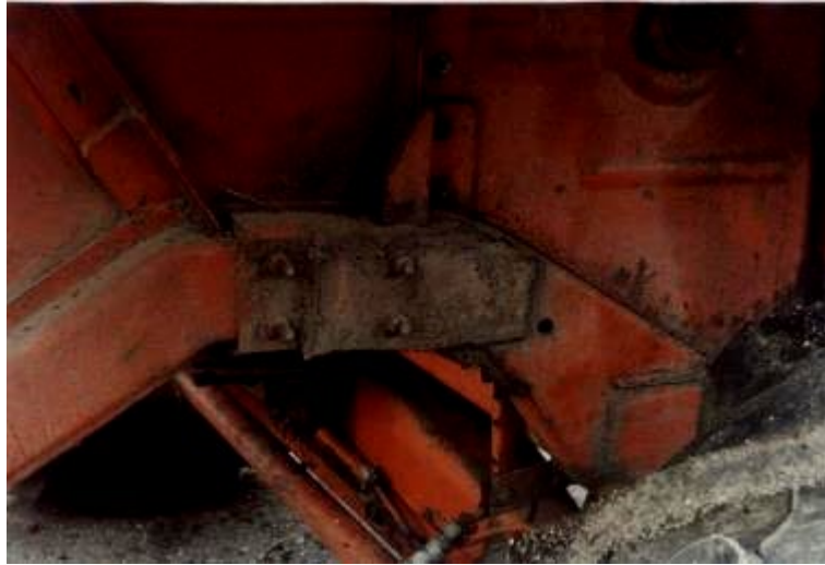
Рисунок 3.1 - Тріщина рами комбайна і ремонт в господарських умовах
