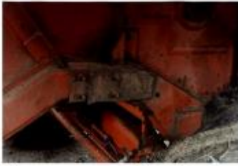
Тріщина рами комбайна і ремонт в господарських умовах
