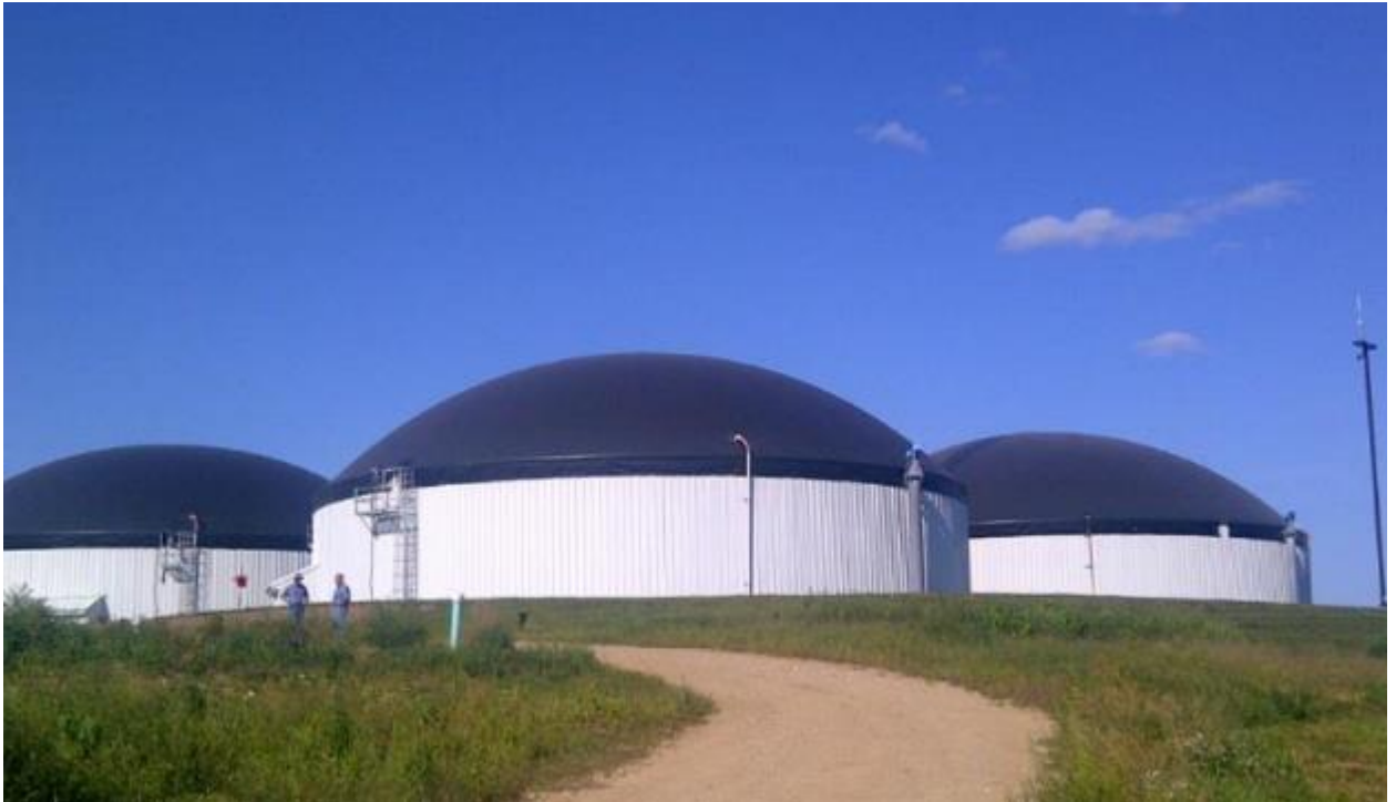
Рисунок 1.2 - Біореактор з повним перемішуванням
