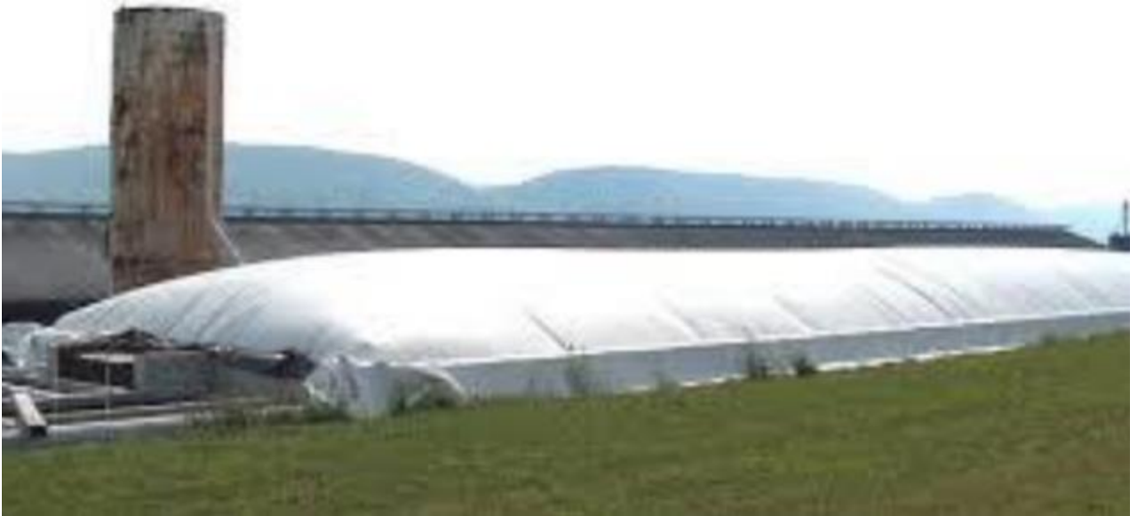
Рисунок 1.3 - Поточковий біореактор
