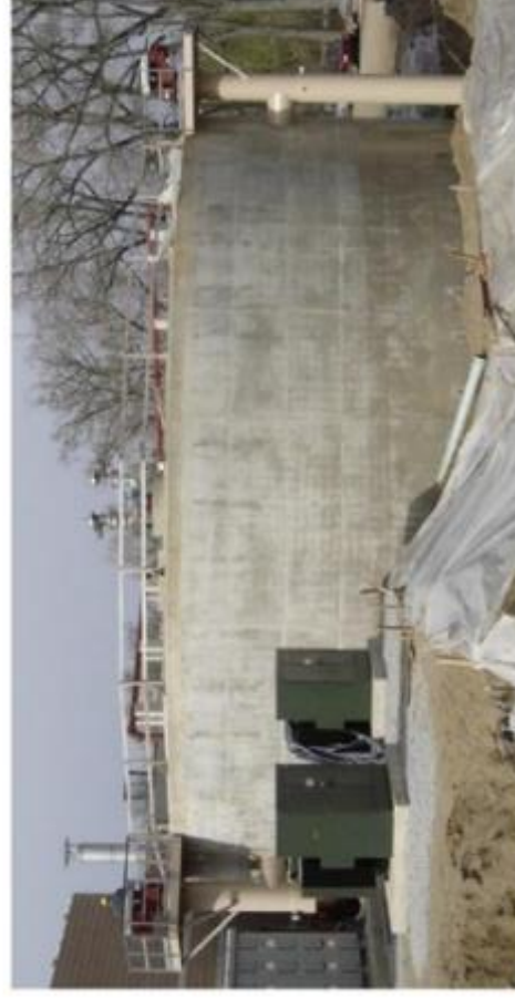
Рисунок 6 - Система гідравлічного перемішування з зовнішньої циркуляційною трубою
