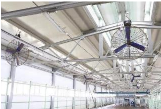
Рисунок 2.5 – Система забезпечення мікроклімату в корівнику з безприв’язним боксовим утриманням
