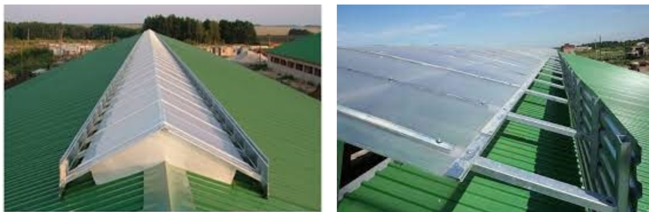
Рисунок 2.4 – Загальний вид світло-вентиляційного дашка
