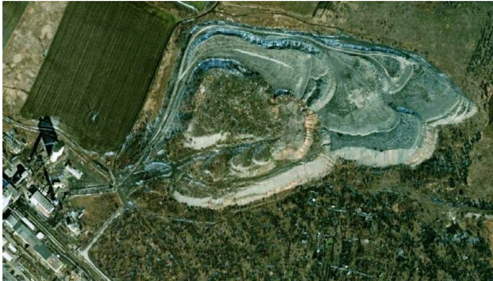
Рисунок 2.2. – Вигляд зверху на шахтний відвал в місті Тернівка
