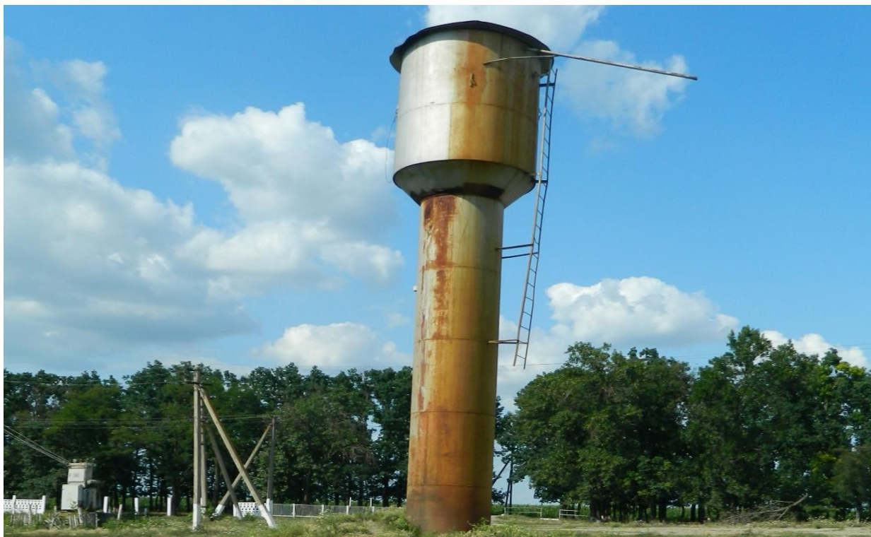
Рис.4. Централізоване водопостачання з використанням насосного обладнання і бапти Рожновського.
