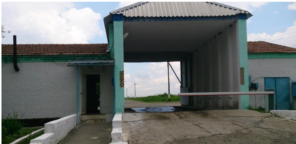
Рис. 10. Дезбар'єр на в'їзді до ПК «Молодіжний»
