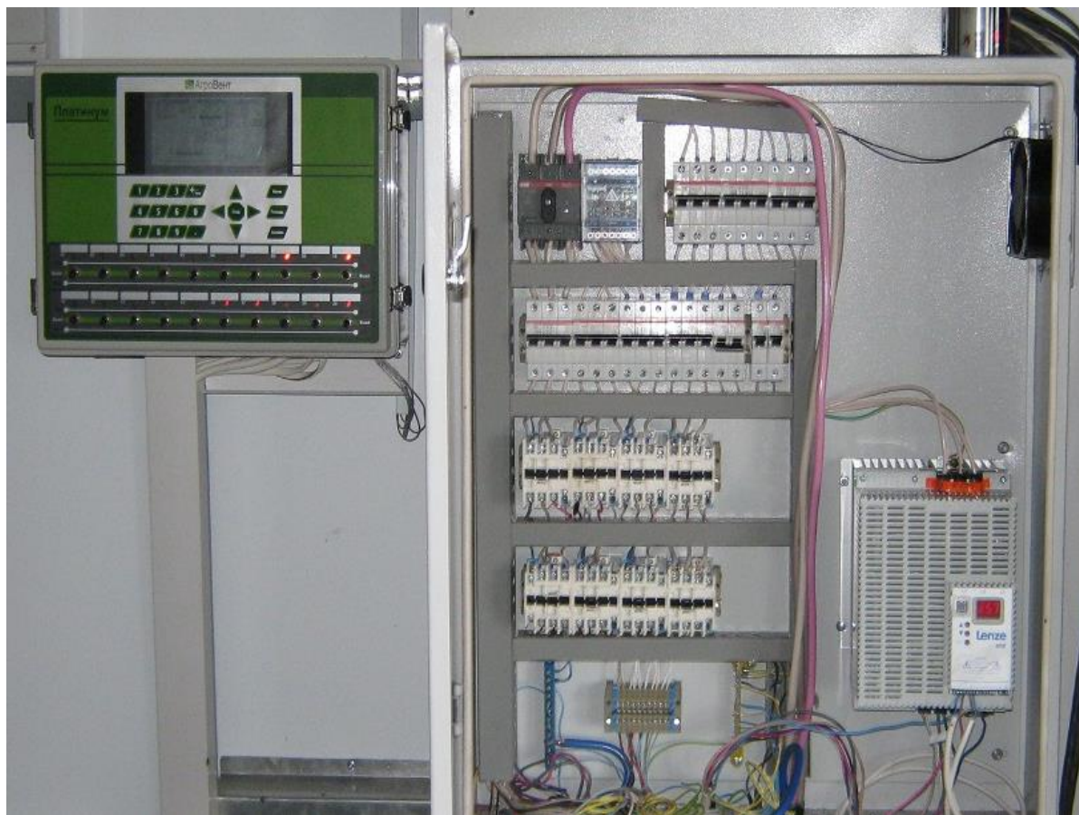
Рис. 2. Контролер мікроклімату «Агровент Платинум»
