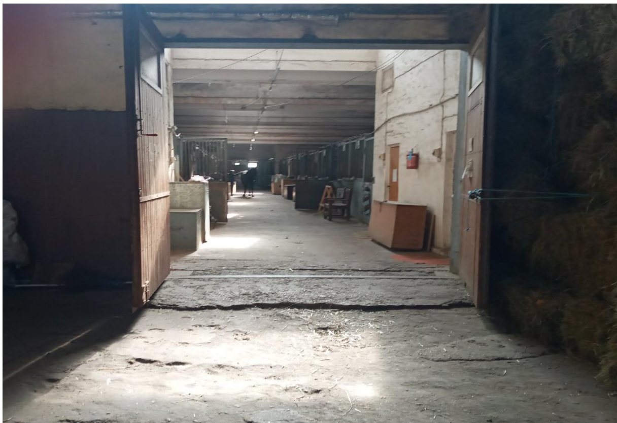
Рис.1. Внутрішня будова конюшні
