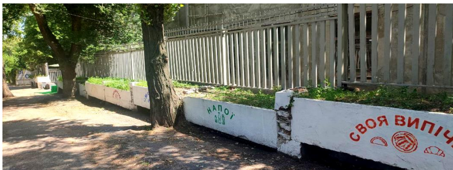
Рис. 3.13 – Бетонні ніші для реконструкції
