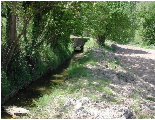
Рис.1.3. Дренажні канали шахти Осор
