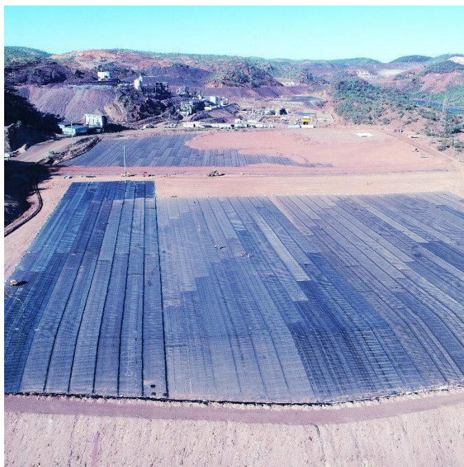
Рис. 1.1. Геомембранне покриття поверхні спланованого шахтного відвалу геотекстилем компанії Coletanche (Франція)
