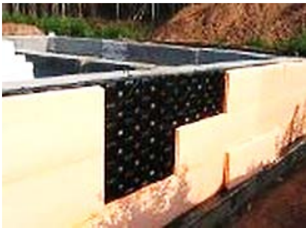
Рис. 4. Утепление с помощью плит Пеноплекса
