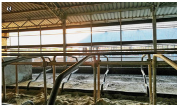
Фото 2. Корпус приміщення полегшеної конструкції на 600 дійних корів: а) внутрішній вигляд приміщення зі сторони кормового столу; б) бокси для відпочинку корів
