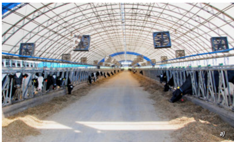
Фото 3. Корпус приміщення ангарного типу з тентовим покриттям на 600 дійних корів: а) внутрішній вигляд приміщення зі сторони кормового столу; б) бокси для відпочинку корів
