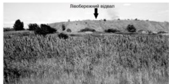
Рисунок 6 – Подтопление территории, прилегающей к Левобережному отвалу
