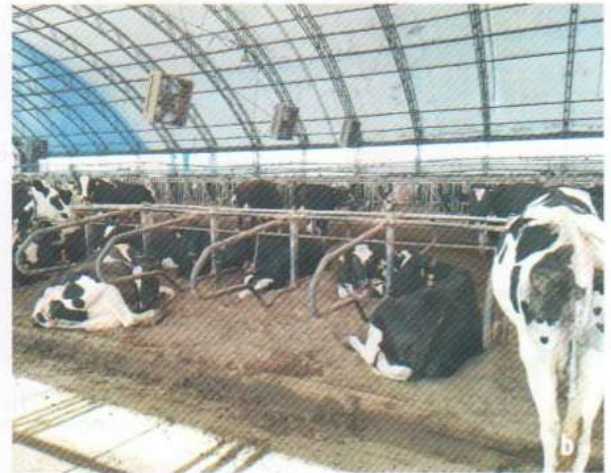
Фото 3. Корпус приміщення ангарного типу з тентовим покриттям на 600 дійних корів: а) внутрішній вигляд приміщення зі сторони кормового столу; б) бокси для відпочинку корів
