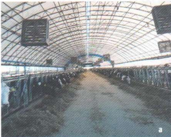
Фото 3. Корпус приміщення ангарного типу з тентовим покриттям на 600 дійних корів: а) внутрішній вигляд приміщення зі сторони кормового столу; б) бокси для відпочинку корів
