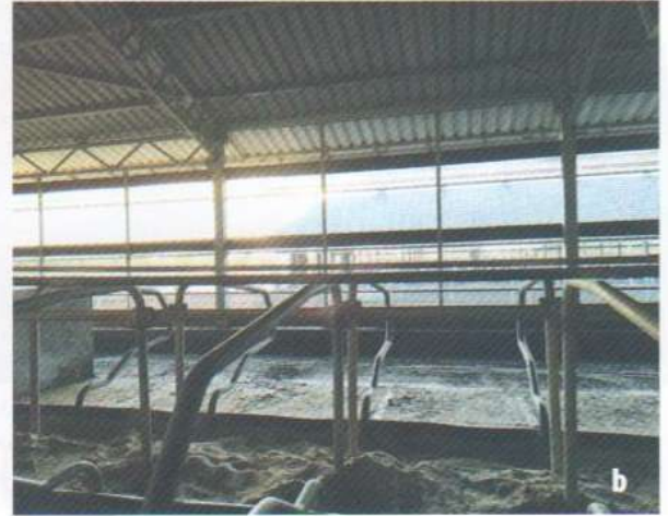
Фото 2. Корпус приміщення полегшеної конструкції на 600 дійних корів: а) внутрішній вигляд приміщення зі сторони кормового столу; б) бокси для відпочинку корів
