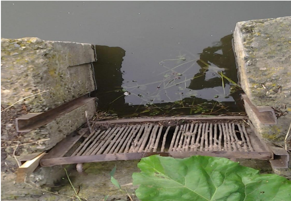
Рис. 4. Донний водоспуск(вирощувального ставу)
