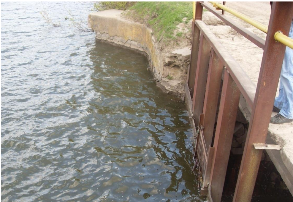
Рис. 4. Донний водоспуск(вирощувального ставу)
