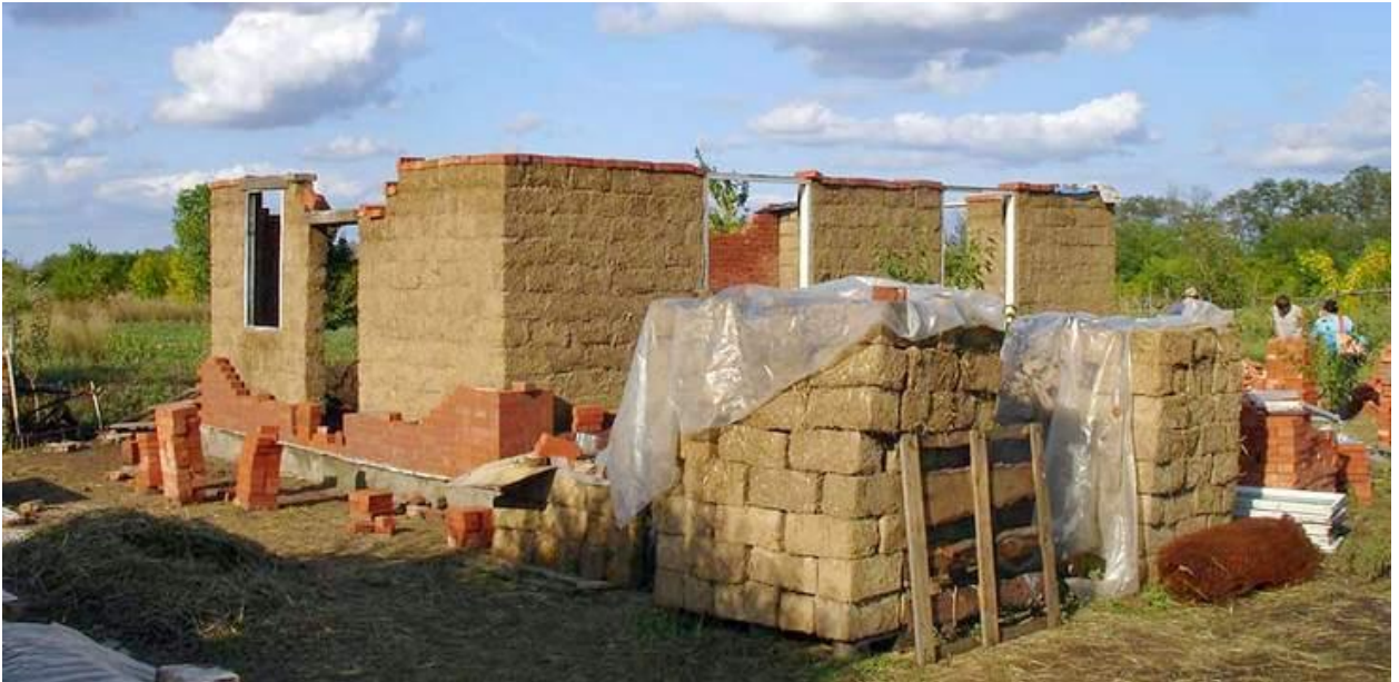
Рис. 4.2 – Будівництво із саману
