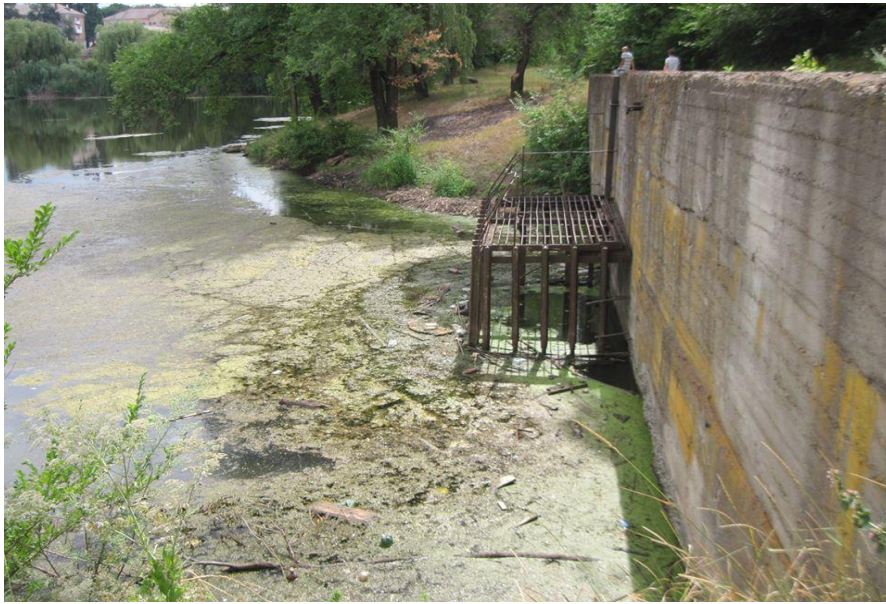
Рисунок 4.12 – Стан русла та пропускна споруда дериваційного тунелю №2 р. Саксагань
