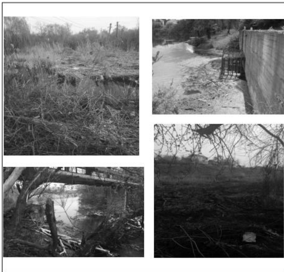
Рисунок 1.2 – Стан русла річки Саксагань на ділянці від «Кресівського» водосховища до «Деривационного» туннелю № 2
