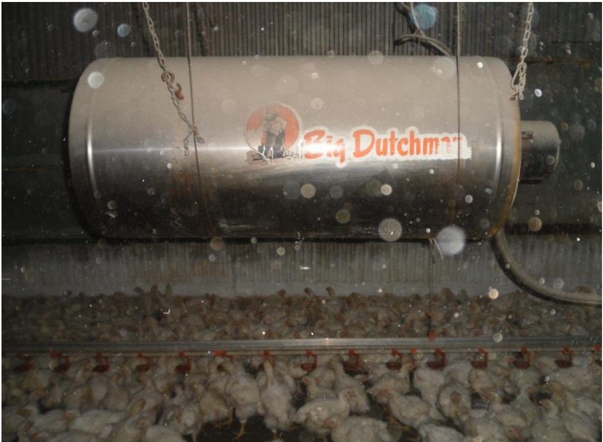
Рис. 6. Пушка для обігріву пташника
