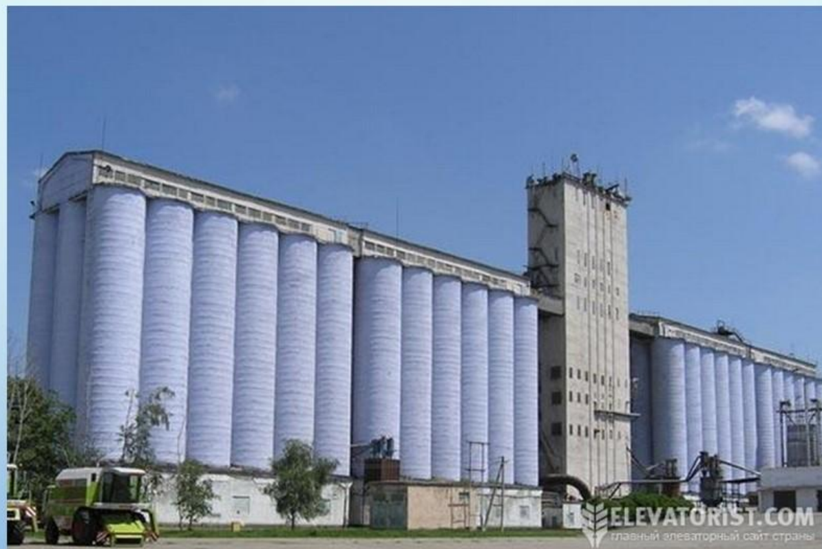
ЗАЛІЗОБЕТОННИЙ ЕЛЕВАТОР З ПРИВ'ЯЗКОЮ ДО РОБОЧОЇ БАШТИ
