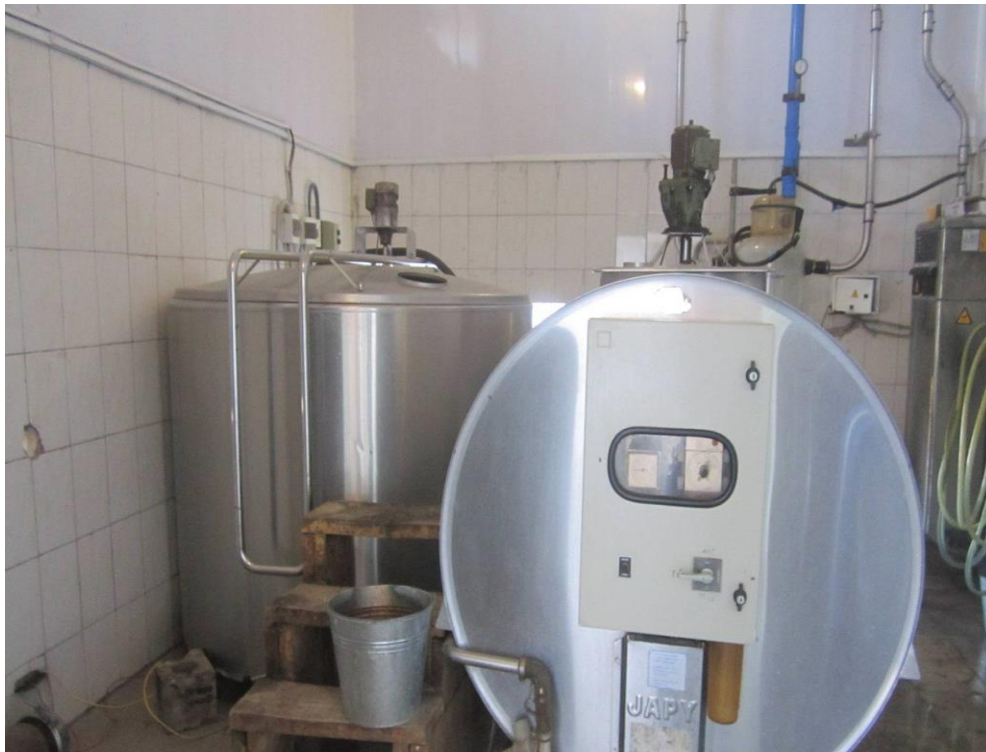
Рис. 2. Резервуар охолодження молока
