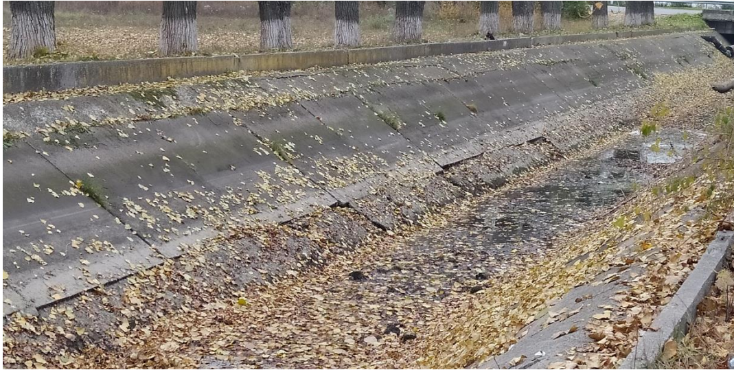
Рисунок 1 – Зовнішній вигляд залізобетонних конструкцій магістрального каналу
