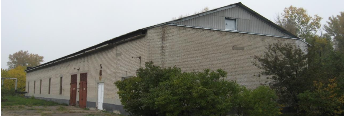
Рисунок 1 – Будівля насосної Ломовської насосно-фільтрувальної станції
