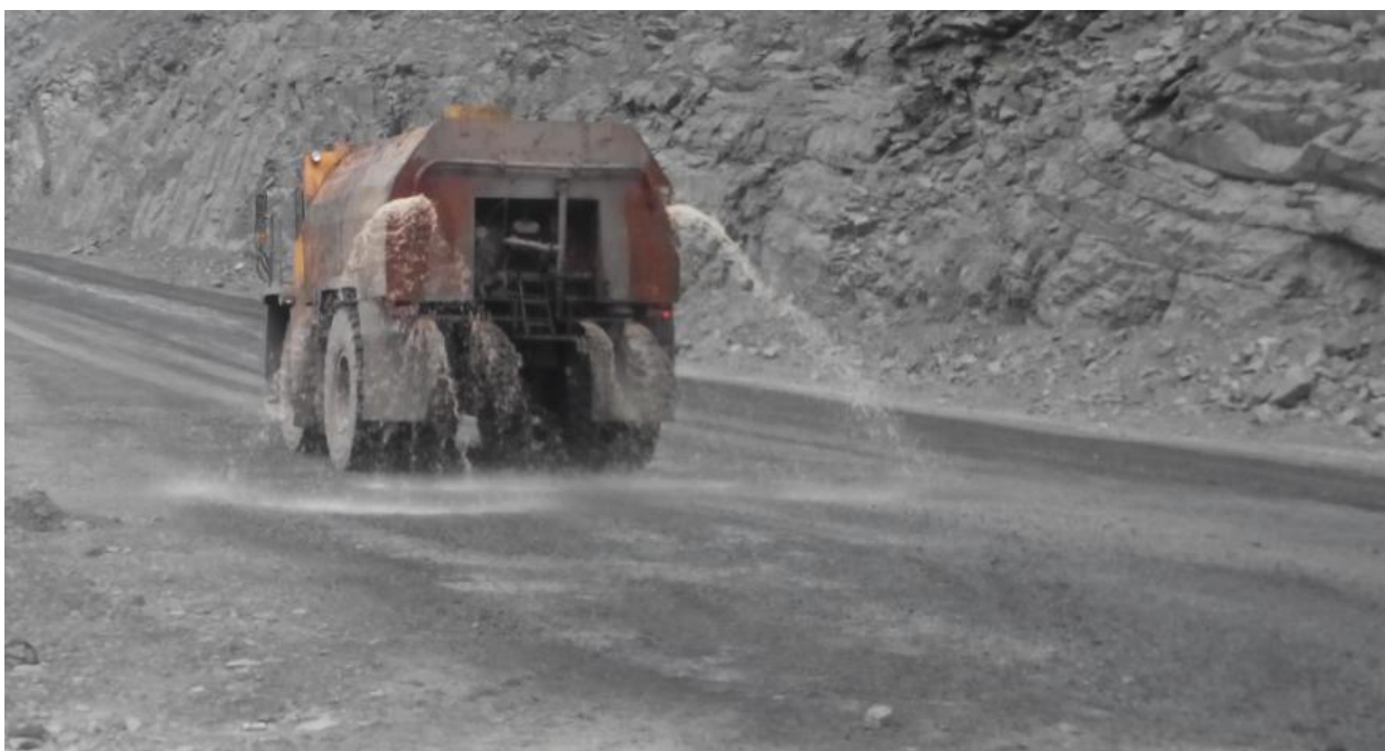
Рис.1 Нанесення водного розчину реагенту Лексол на поверхні доріг, що запилюються
