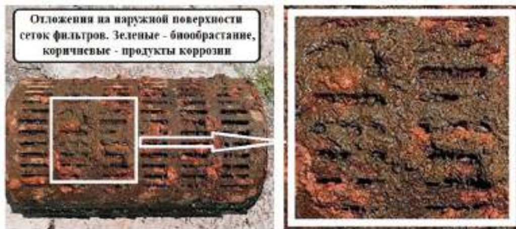
Рисунок 8. Стан зовнішніх поверхонь сіток фільтрів насосних станцій при розбиранні на початку випробувань після тривалої експлуатації. Ліворуч – загальний вигляд сітки фільтра, праворуч – збільшений фрагмент.
