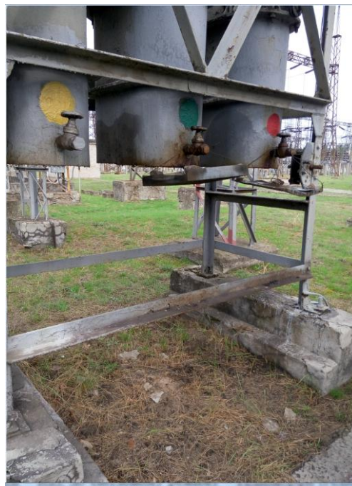
Рис. 3.1 – Дослідна ділянка на електричній підстанції.
