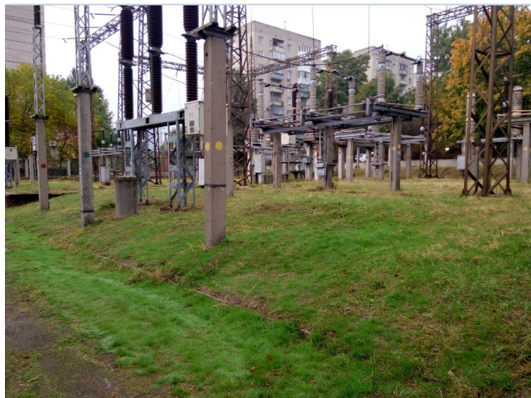
Рис. 2.1. Загальний вид електричної підстанції.
