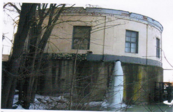
Рис. 1. Будівля насосної Кайдацької насосно-фільтрувальної станції м. Дніпро
