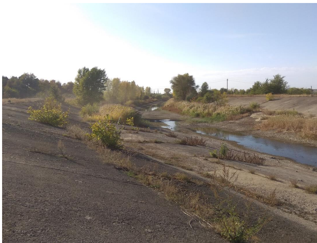
Рис. 4.1. Наднизькі рівні води на трасі каналу: А – перед переливними спорудами; Б – між насосними станціями в Харківській області (фото автора).
