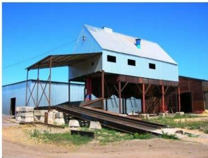
Рисунок 1.8 – Зерноочисний агрегат ЗАВ-40 (загальний вигляд)
