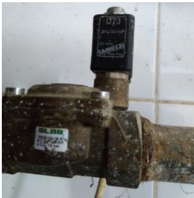
Рисунок 3.15 – Соленоїдний клапан з котушкою
