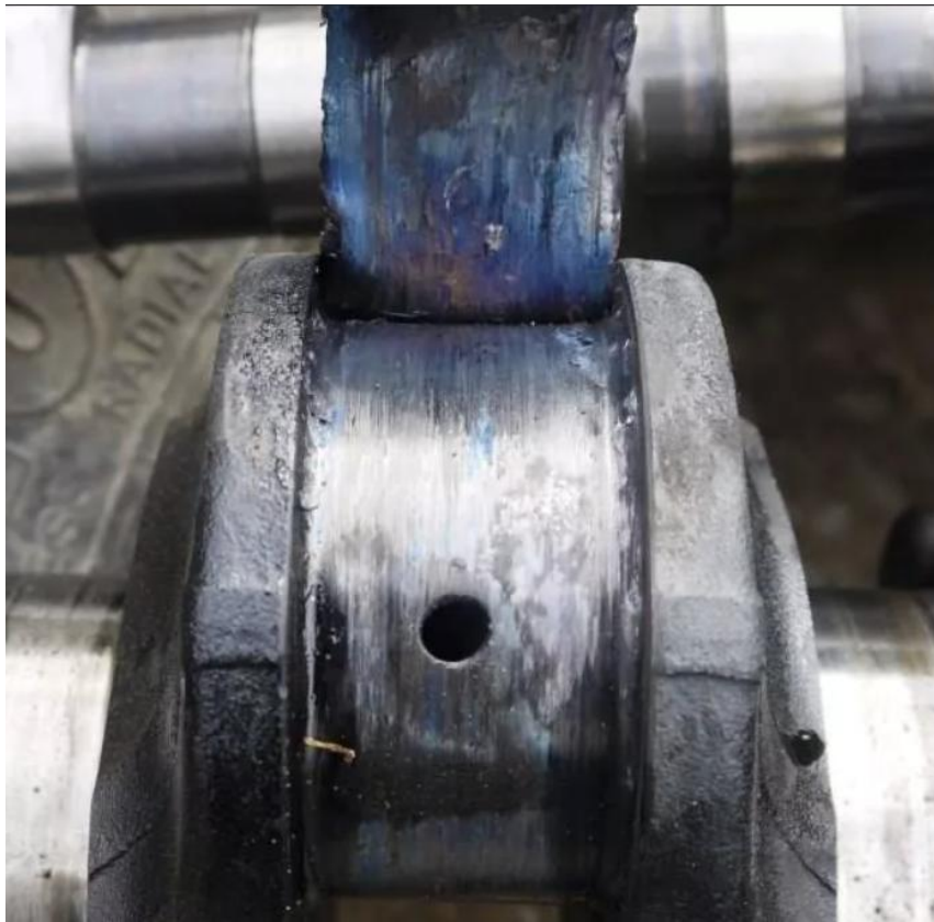
Рис. 1.8. Приварювання вкладиша до шийки внаслідок проворачування валу
