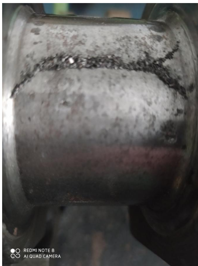
Рис. 1.11. Валик магнітного індикатору над тріщиною в середній частині шийки валу
