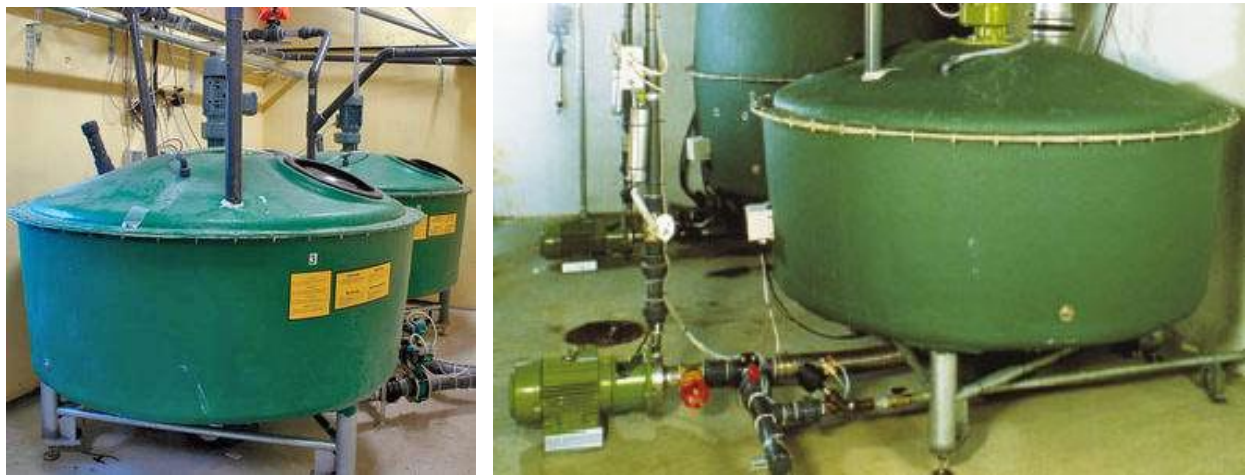
Рисунок 1.7 - Змішувачі системи Aco Funki.
