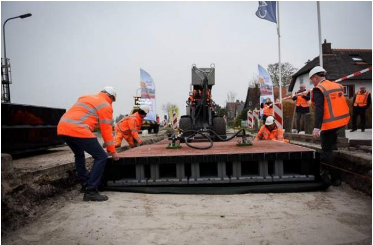
Рис. 3. – Монтаж ортотропних дорожніх плит.
