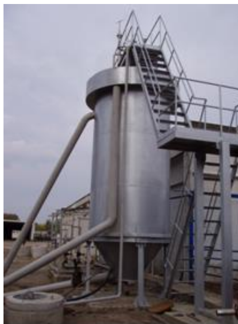
Відстійник-флотатор діаметром 2,4 м
